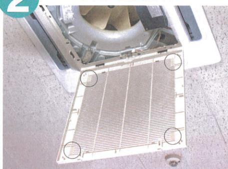
3 「AT254吸着フィルター」をカバーの裏側に取り付けます。
